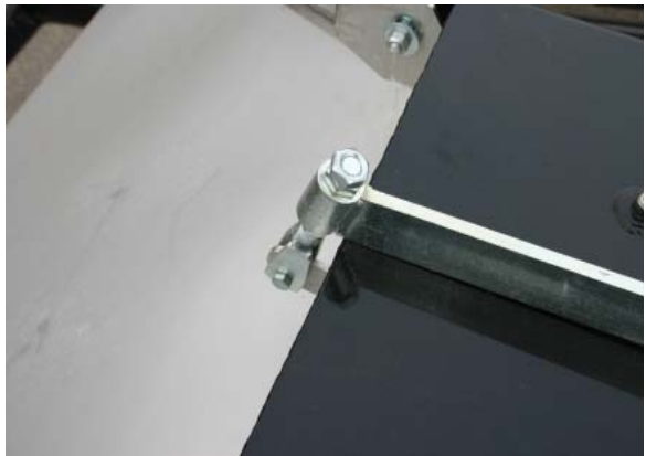
Jam nuts on hold-down bar
