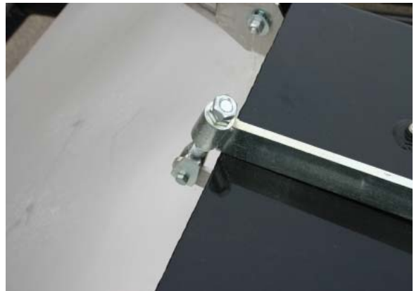
Jam nuts on hold-down bar
